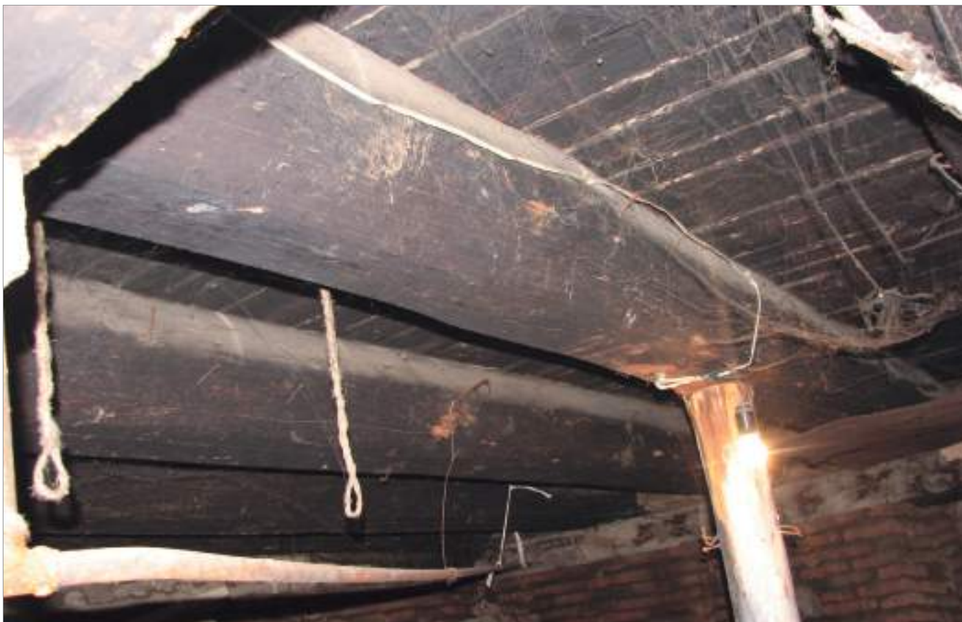
სურ.14. ბ.ახოსპირელის I ჩიხი, საცხოვრებელი სახლი №4/3, ნახევარსარდაფის დასავლეთი ნაწილის ბრტყელი გადახურვა, 2015 წ.
