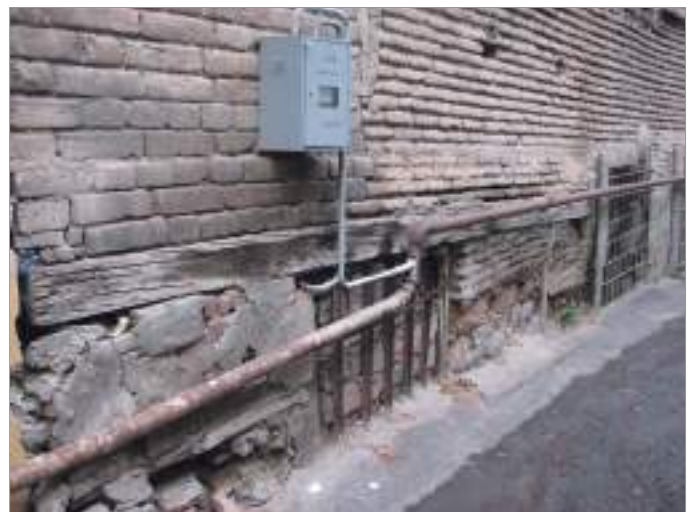
სურ.11. ბ.ახოსპირელის I ჩიხი, საცხოვრებელი სახლი №4/3, პარალელურად გაყოლებული ხის სარტყლები ფასადზე, 2015 წ.
