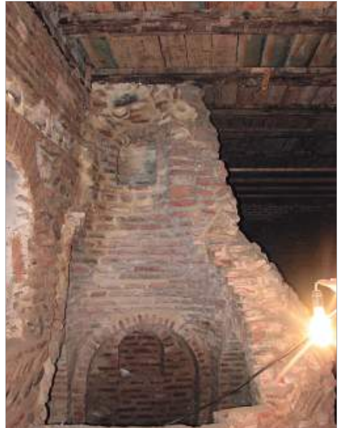
სურ.27. ლ. გუდიაშვილის მოედანი, საცხოვრებელი სახლი №6/1, ძველი სადგომის კონსტრუქციის ზედა ნაწილი რესტავრაციის შემდეგ.
