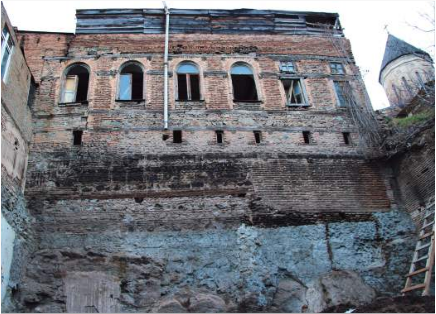
სურ. 19. ასკანის ქ. №11 სახლი, მრავალშრიანი საფასადო კედლის ხედი ქვედა ტერასის სახლის დემონტაჟის შემდეგ, 2024
