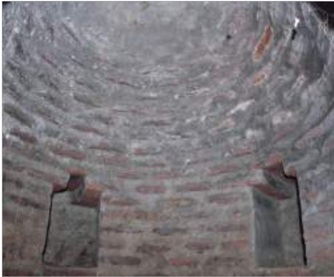
სურ.31. ლ. გუდიაშვილის მოედანი, საცხოვრებელი სახლი №6/1, კედლის სისტემაში გამართული სფერულკამარიანი სათავსი სატრაქე ნიშებით.
