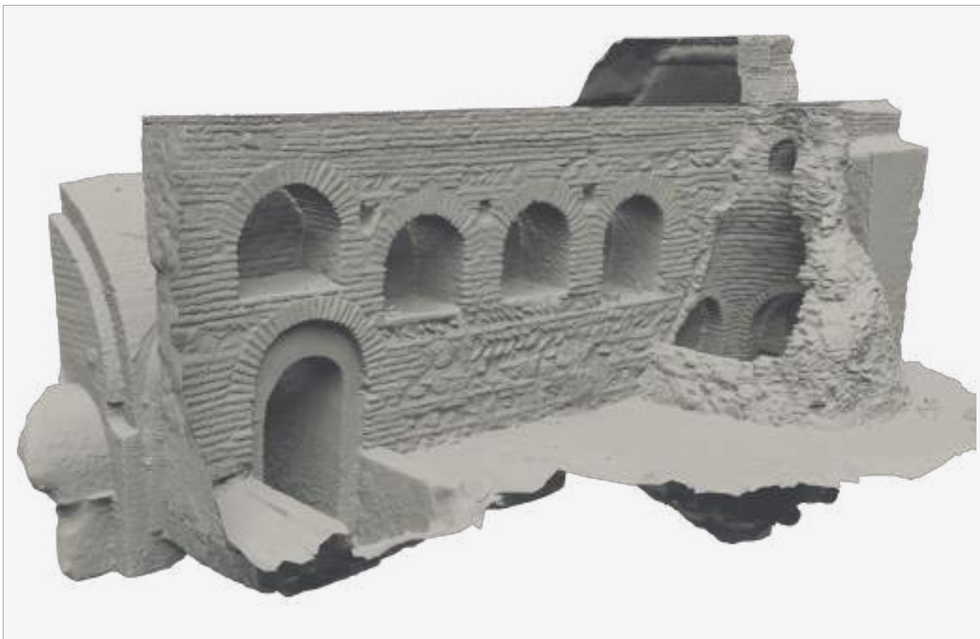
3. ფოტოგრამეტრიული 3D მოდელი, ლ.გუდიაშვილის მოედანი, საცხოვრებელი სახლი №6/1, ზედა დონის სადგომი ბოთლისებური კონსტრუქციით.
