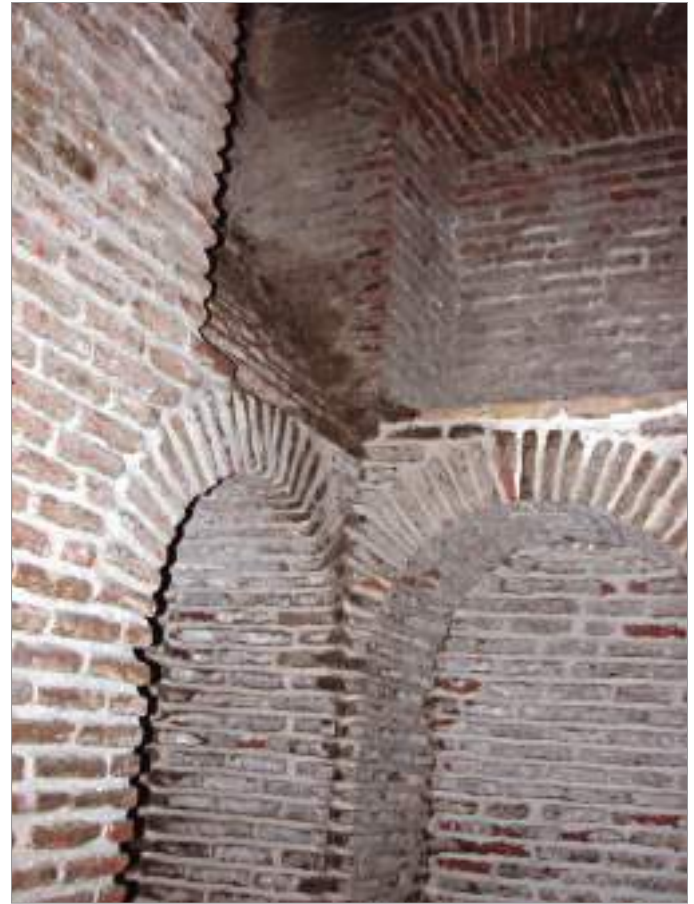
სურ. 9. ლ. გუდიაშვილის მოედანი, საცხოვრებელი სახლი №2, სარდაფის კედლების ორ რეგისტრად დანაწევრება, ფრაგმენტი. 2019
