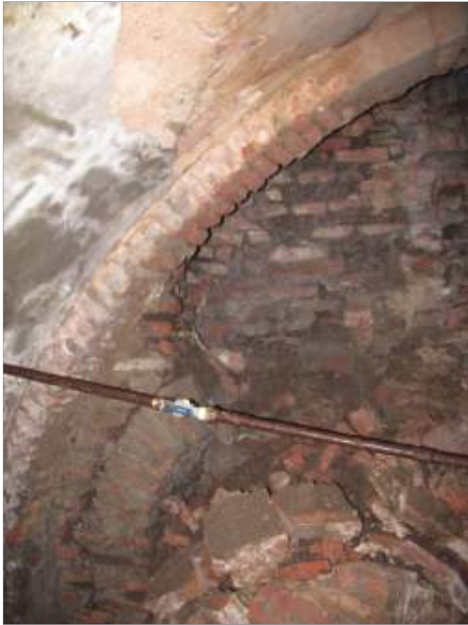
სურ. 9. ორსაფეხურიანი საყრდენი თაღის ნანგრევი ჩრდილო-აღმოსავლეთ კუთხესთან, 2015
