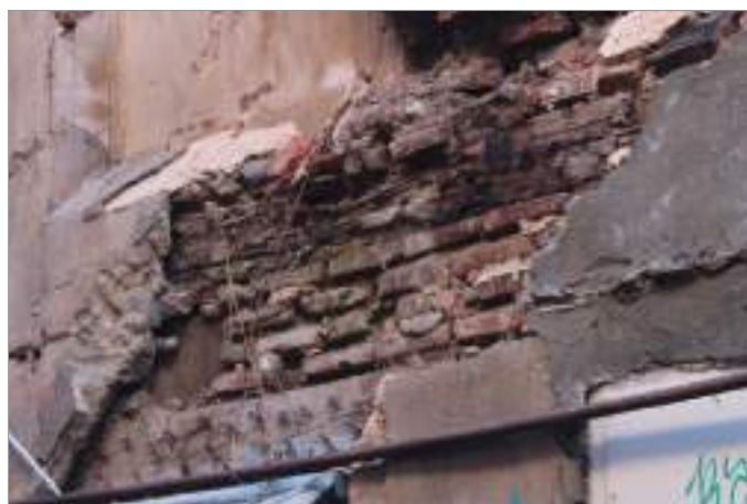
სურ. 6. №20/6 სახლის უკანა კედელზე აგურის წყობაში ჩატანებული ხის ძელები. 2025
