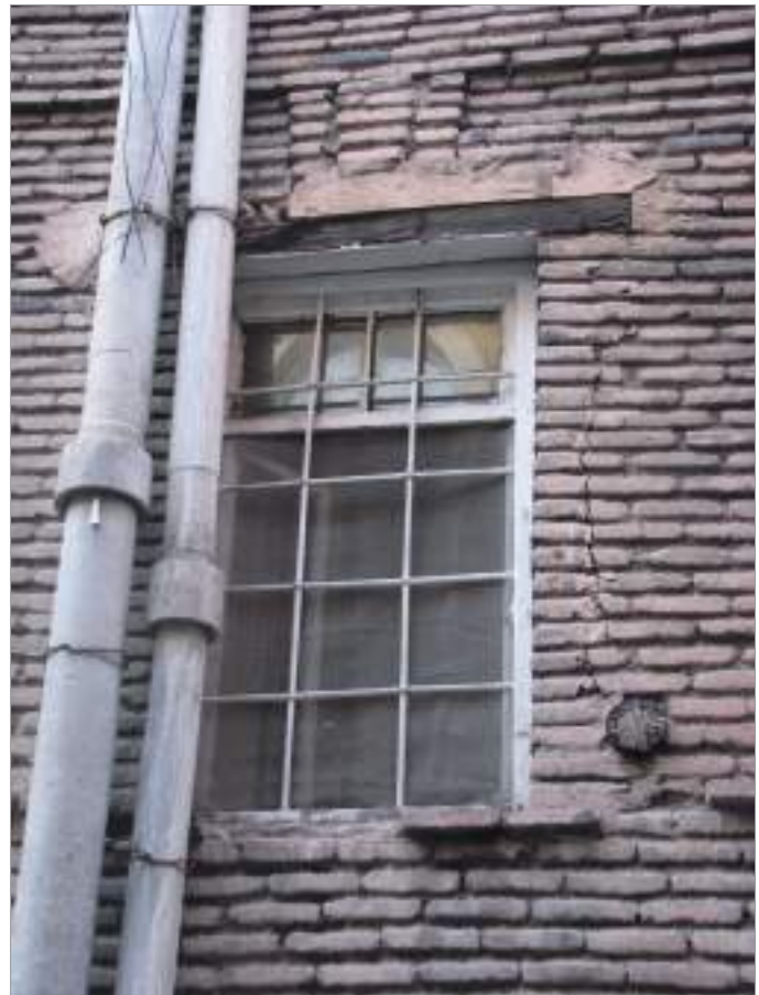
სურ.9. ბ.ახოსპირელის I ჩიხი, საცხოვრებელი სახლი №4/3, აგურის წყობით გამოყვანილი „საჭეჭი ქვით“ დასრულებული პირველი სართულის ღიობი, 2015 წ.
