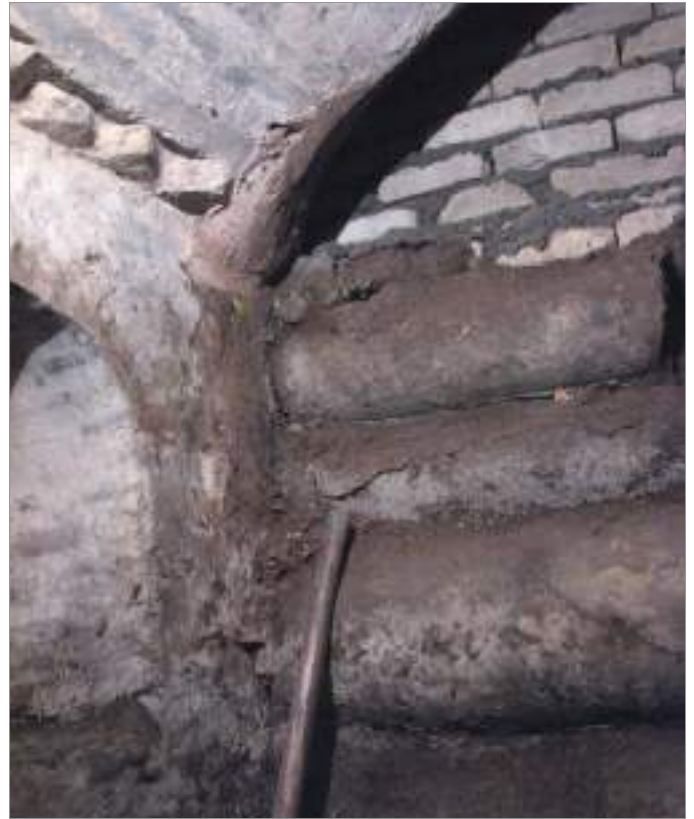
სურ.33. ლ. გუდიაშვილის მოედანი, საცხოვრებელი სახლი №6/1, წრიული კოლონებით ამოქოლილი ღიობი, რომელიც თავდაპირველად ჩიხიდან შემოსასვლელს წარმოადგენდა.
