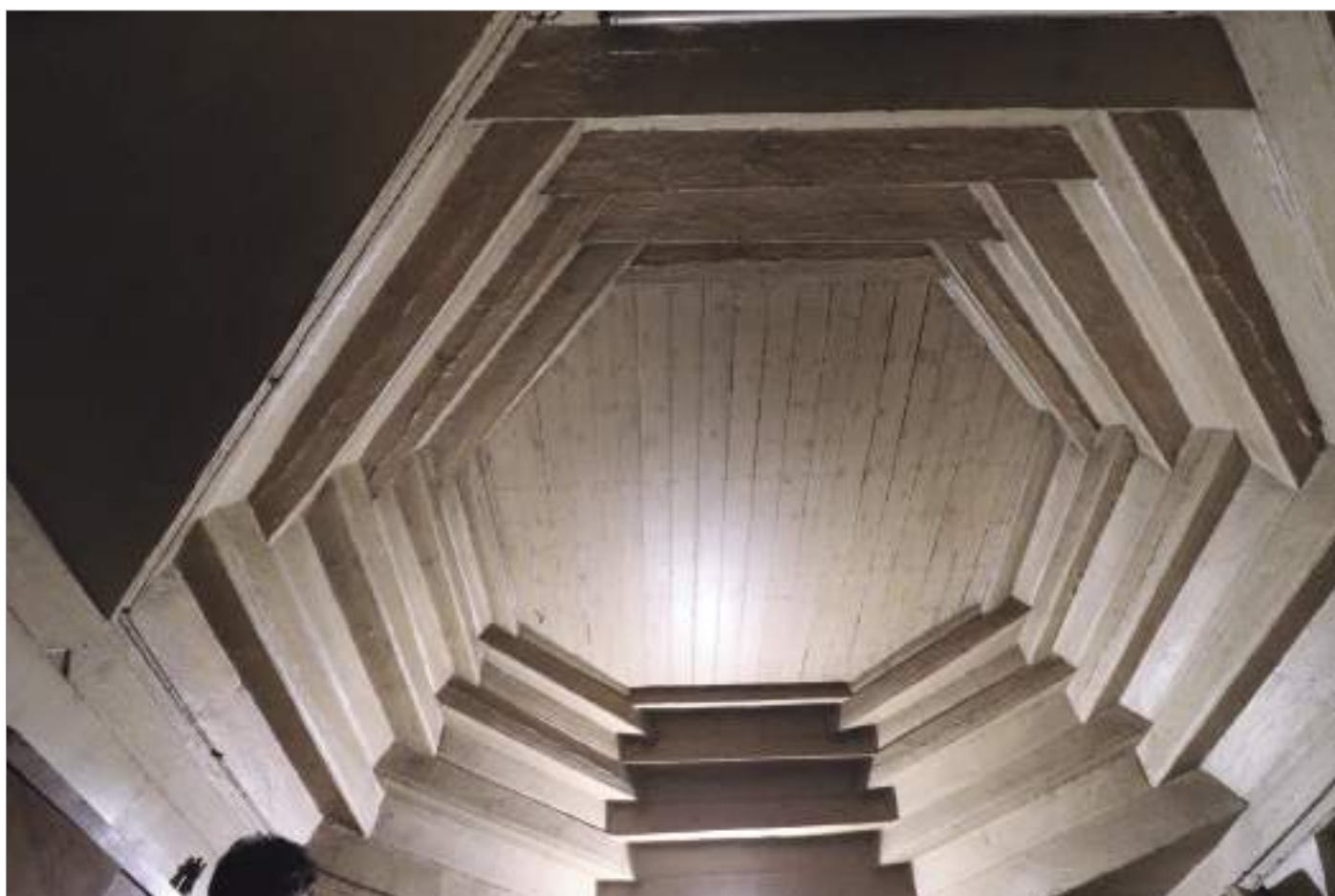
სურ.16. ახალციხე, გოგებაშვილის ქუჩის მიმდებარე ჩიხი, დარბაზის არასრულად შემონახული გვირგვინი. 2023
