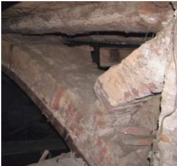
სურ.11. გ. აბესაძის ქ. №21, ქუჩისპირა ნაგებობის სარდაფი, კამარის არმირებული საბჯენი თაღი, 2016
