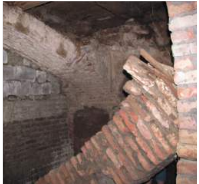
სურ.12. გ. აბესაძის ქ. №21, ქუჩისპირა ნაგებობის სარდაფი, დაზიანება ინტერიერში, 2016
