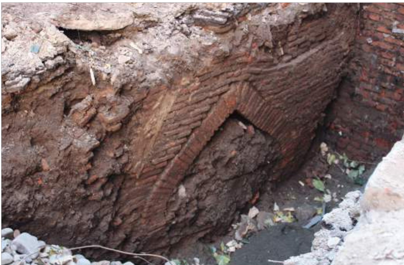
სურ. 2. ბ. ახოსპირელის ქ. №7, ეზოს საფარს ქვეშ მოქცეული აგურის კედელი შეისრული თაღით, 2019
