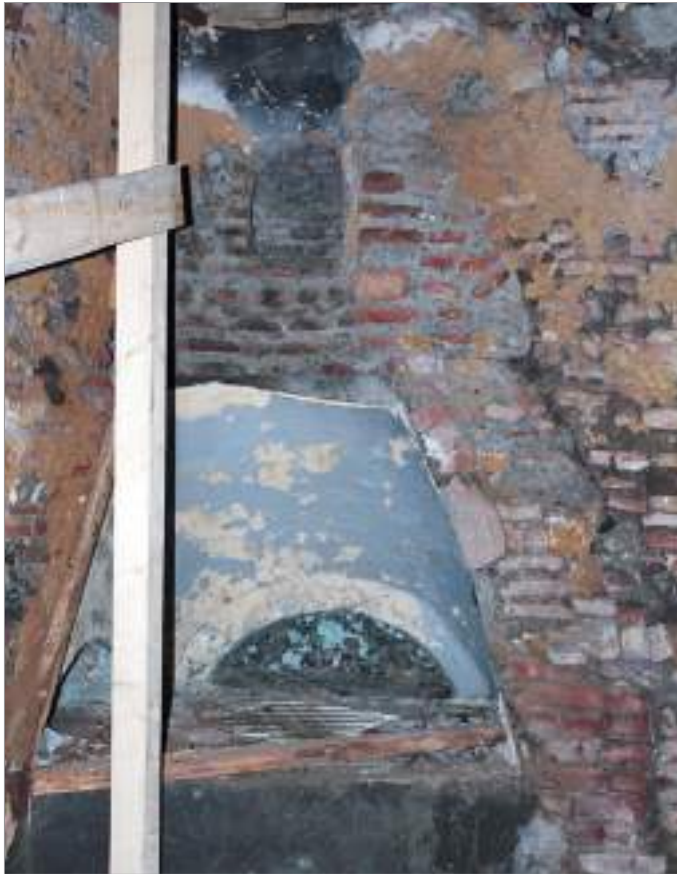
სურ.26. ლ. გუდიაშვილის მოედანი, საცხოვრებელი სახლი №6/1, ძველი სადგომის კონსტრუქციის ზედა ნაწილი რესტავრაციამდე.
