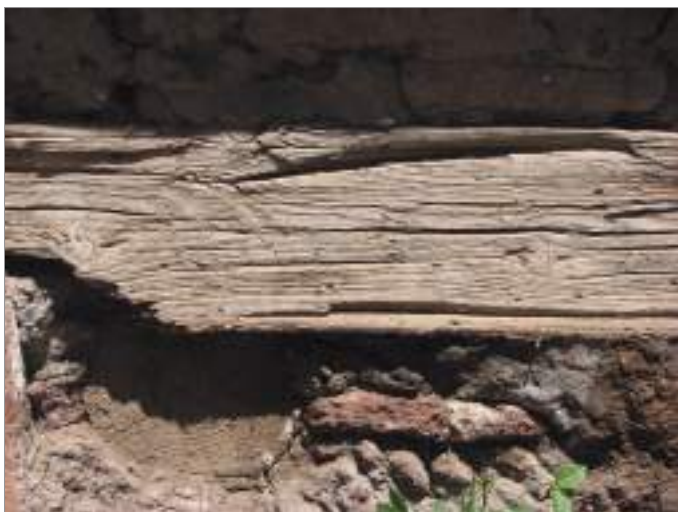
სურ.10. ბ.ახოსპირელის I ჩიხი, საცხოვრებელი სახლი №4/3, მრგვალი კოჭის თავი და ხის სარტყლის ფრაგმენტი ფასადზე, 2015 წ.
