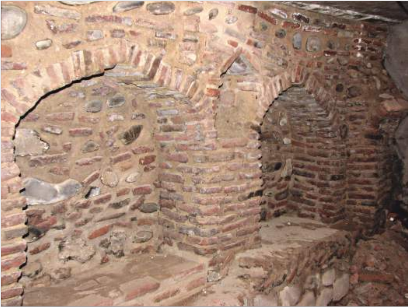
სურ.32. 1. ბ.ახოსპირელის ქ. №7, საცხოვრებელი სახლის კონსტრუქციული გამაგრების დროს აღმოჩენილი XVII ს-ის სადგომის ფრაგმენტი.
