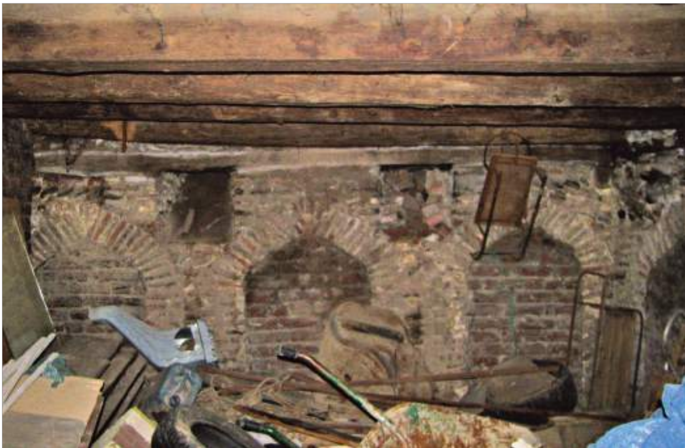
სურ. 4. გ. ჭიბლაძის ქ. №5, სარდაფის უკანა კედელი ჩაშენებული ნიშებით, 2015
