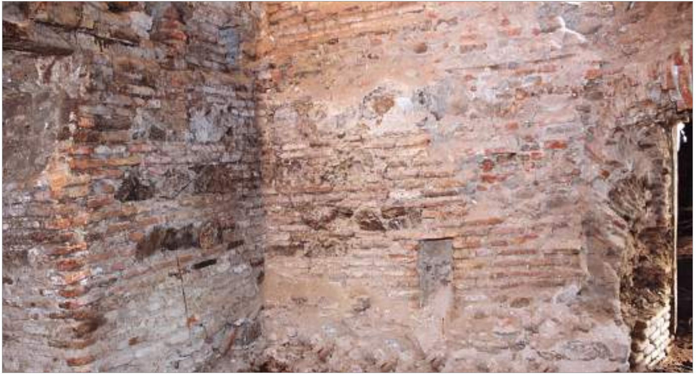
სურ. 20. ლ. გუდიაშვილის მოედ. №7/3 ქვედა დონის სარდაფი, განსხვავებული წყობის კედელი, 2018
