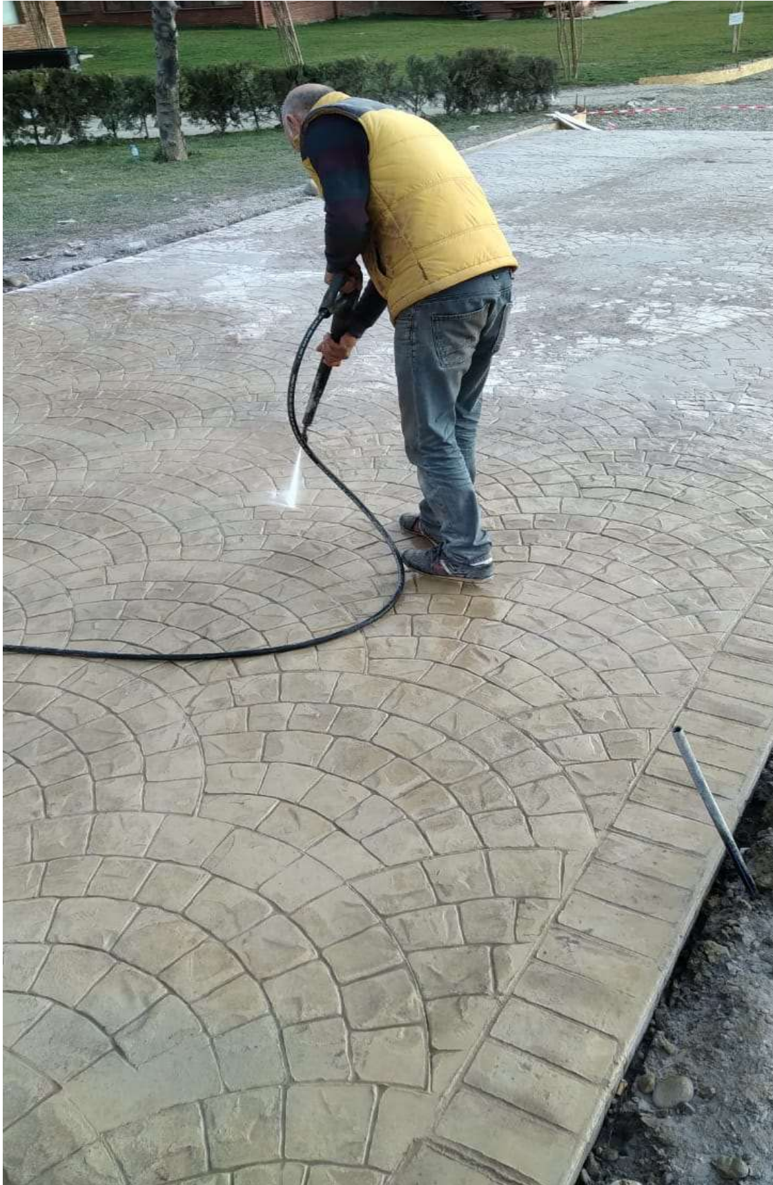
სურათი №9 - ბექდური ბეტონი FloorCrete C32/40 S3 D10 W6 F200, კაჭრეთი
