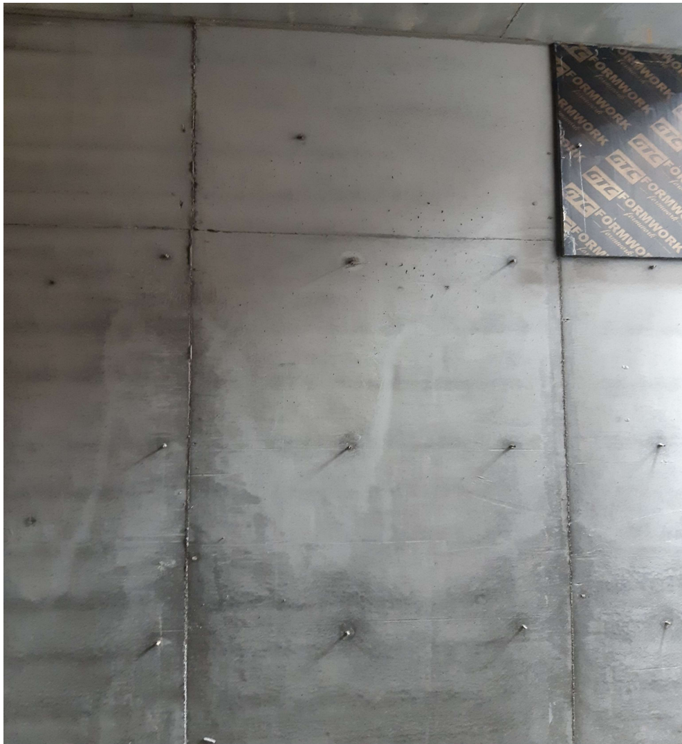
სურათი№38 - ზედმეტი და არათანაბარი ვიბრაციისგან გამოწვეული დეფექტი
