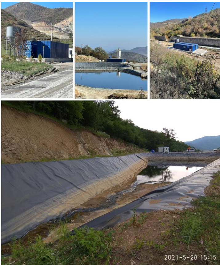
ნახ. 4. ქიმიური გამწმენდი ნაგებობები: 1) მდინარე კაზრეთულაზე ქიმიური გამწმენდი ნაგებობა, 2) კვირაცხოვლის ღელეზე ქიმიური გამწმენდი ნაგებობა, 3) მე-4 სასაწყაროს დრენირებული წყლების შეკრება და ქიმიური გამწმენდი ნაგებობა, 4) მე-3 სასაწყაროს დრენირებული წყლების შეკრება და საწარმოო ციკლში დაბრუნება.
