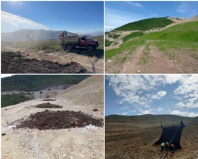
ნახ. 6. ა) სარეკულტივაციო ტერიტორიის განეიტრალება და ბიოკომპოსტის შეტანა. 2020 წელი. ბ) ციცაბო ფერდობზე ეროზიის საწინააღმდეგო მემბრანის დაფენა ფერდის სტაბილიზაციის მიზნით. 2020 წელი
