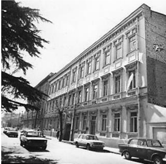
სურ. 7.3. პეტრე მელიქიშვილის სახელობის ქიმიის ინსტიტუტი, სადაც 1945 წელს დაფუძნდა ლითონისა და სამთო საქმის ინსტიტუტი
